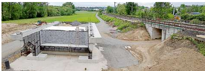
Während einer viertägigen Sperrung der Strecke wird die alte Bauwerk und ein Teil des Bahndammes abgetragen und die 1500 Tonnen schwere neue Brücke eingeschoben. Foto: Günther
